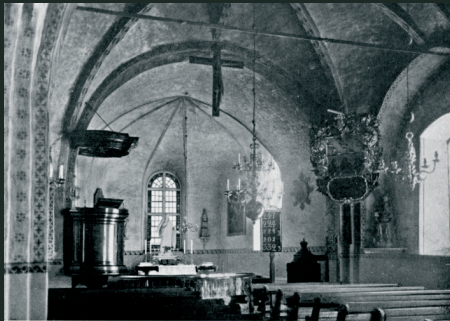
Kyrkans interiör före 1950 års renovering. Notera t ex korfönstret, som murades igen då Kristusfiguren som byttes ut mot det stora krucifixet, Madonnan och S:t Olof har kommit ned från vinden. Det Sölverbergska begravningsvapnet sitter här på sin ursprungliga plats. Bilden är tagen 1936.
